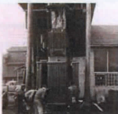
▲ 修理品トランス搬入
